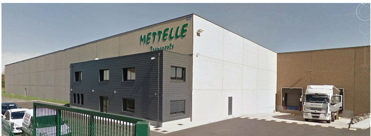
Figure 10 : Vue de l'entrepôt actuel
